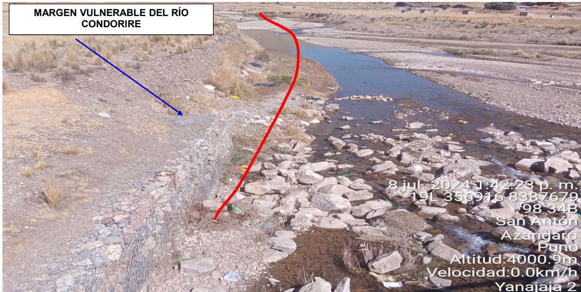
FIGURA N°02: LA AFECTACION DE AREAS AGRICOLAS LAS QUE ESTAN PROPENSAS ANTE UNA CRECIDA DEL RÍO CONDORIRE Y LA EROSION EN LA MARGEN DERECHA E IZQUIERDA
